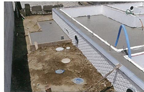
設備配管工事も同時施工できます。
