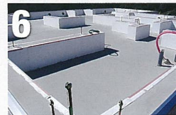
■完了:型枠設置からコンクリート打設まで2日で(4~5人)完了できます。天候に左右されない工程管理ができます。
