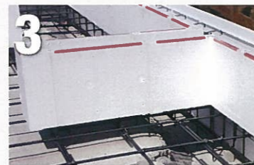
■浮かし型枠の施工:独自開発技術により、浮かし型枠が簡単に設置できます。
