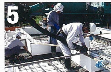
■コンクリート打設:独自開発された型枠は強度に優れ、ハラミや浮き現象が少なく、単管などによる押さえも不要です。
