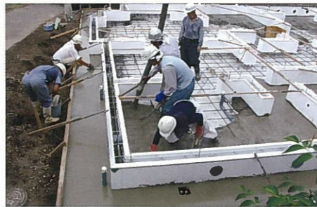
玄関ポーチや犬走りも同時打設。型枠の際まできれいに ならして完成。
