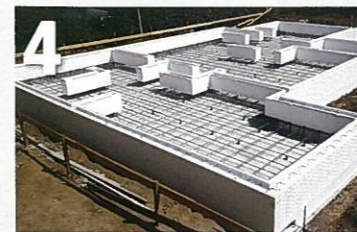
■組立完了:床面積20坪(作業員3名)の場合、型枠組立が半日で終了。コンクリート打設を同日に行うことも可能です。
