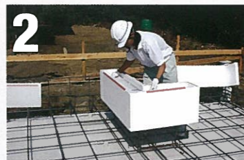
■型枠設置:ユニット式なので現場カット不要。軽量なので女性でも簡単に取り扱いえます。
