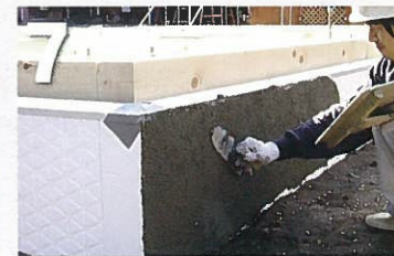
■基礎の表面仕上:型枠を取り外す必要がないため、化粧モルタルを基礎打設と同時に施行できます。
